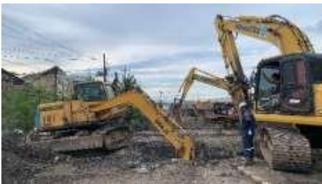
Gambar 7. Excavator (Sumber: Dokumen Pribadi, 2025)
