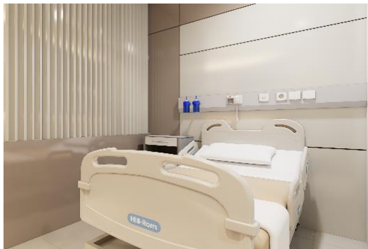
Gambar 11. Fasilitas Headwall Pasien Ruang VIP&VVIP (Sumber : Dokumen Penulis, 2025)
