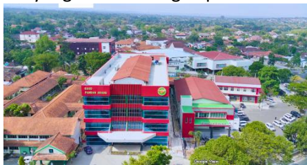
Gambar 2. Gedung Merbabu RSUD Pandan Arang (Sumber : Google Maps, 2025)
