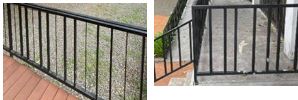
Gambar 5. Railing Pada Sister City Park Bandung (Sumber: Dokumentasi Penulis, 2025)
