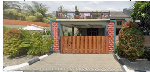
Gambar 6. Tampak depan bangunan awal (sumber : Dokumentasi Peneliti 2025)
