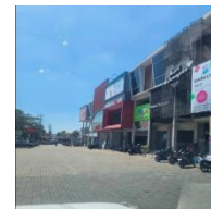
Gambar 5. Ruko Citadel Square (Sumber : Dokumentasi Penulis, 2025)
