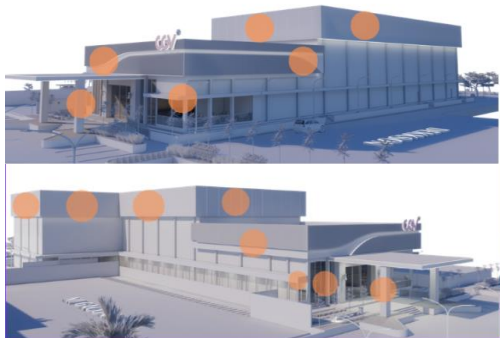
Gambar 6. Penggunaan ACP pada fasad CGV (Sumber : Dokumentasi Penulis, 2025)
