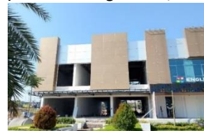
Gambar 4. Ruko Citadel Square (Sumber : Dokumentasi Penulis, 2025)
