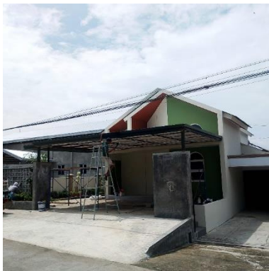
Gambar 1. Tampak luar bangunan baby spa sebagai objek penelitian di Sukoharjo.
