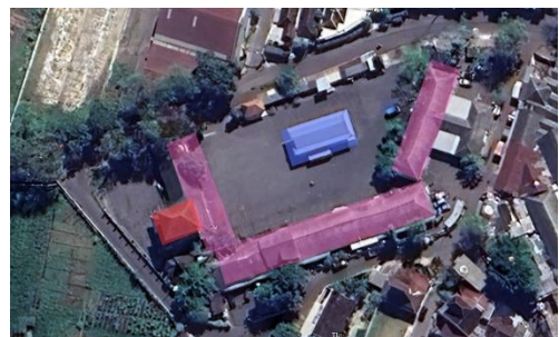
Gambar 4. Peta Sebaran Kerusakan Fasilitas Terminal Palur
