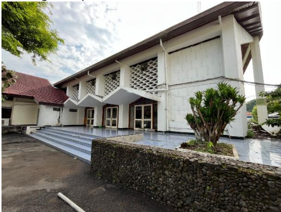
Gambar 1. Kondisi Eksisting Auditorium Imam Barjo (Sumber: Dokumentasi Penulis, 2025)
