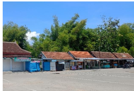
Gambar 3. Fasilitas Pendukung (Sumber: Dokumentasi Penulis, 2025)
