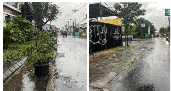
Gambar 6. Kondisi genangan air saat terjadinya hujan pada segmen 3.
