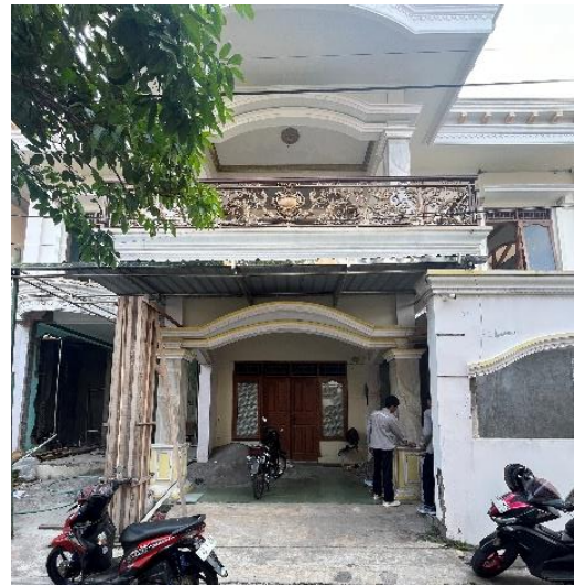
Gambar 2. Tampak Eksisting Bangunan Lama
