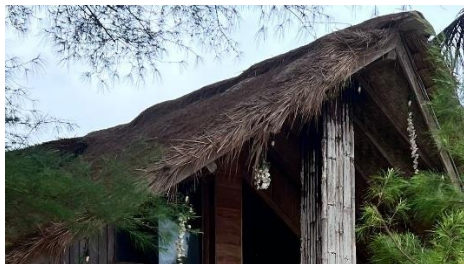
Gambar 7. Bentuk dan detail atap bangunan pesisir (Sumber: Dokumentasi Penulis, 2025)
