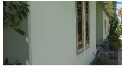
Gambar 5. Detail material dan kondisi dinding bangunan pesisir
