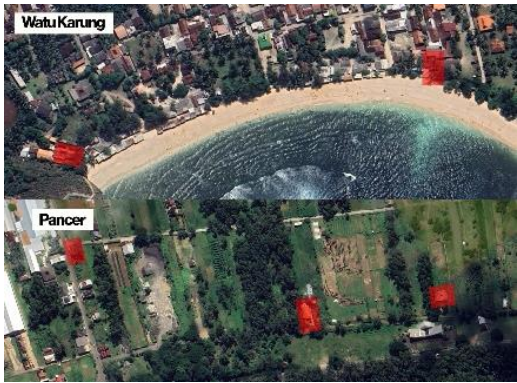
Gambar 3. Kondisi lingkungan sekitar bangunan yang terpapar angin laut (Sumber: Dokumentasi Penulis, 2025)
