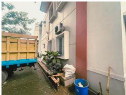
Gambar 3. Lokasi Belakang Gedung Kantor Bidang Cipta Karya.
