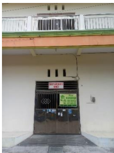
Gambar 2. Kondisi Eksisting (Sumber: Dokumentasi Penulis, 2025)
