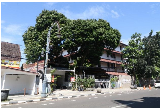
Gambar 7. Kondisi eksisting bangunan sebelum dilakukan revitalisasi (sumber: Hepta Desain, 2021)
