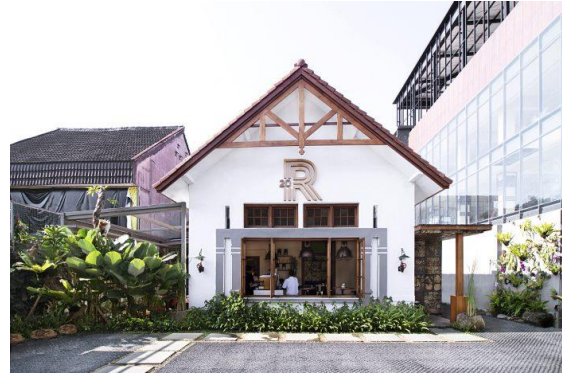
Gambar 8. Kondisi bangunan setelah mengalami revitalisasi (sumber: Archinesia, 2025)
