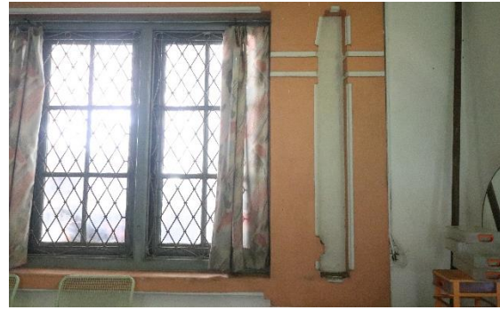
Gambar 2. Kondisi Eksisting Ruang Tamu (sumber: Hepta Desain, 2021)
