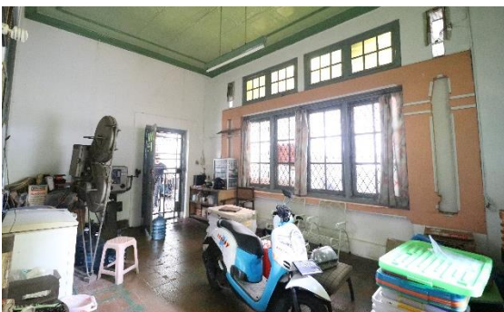
Gambar 2. Kondisi Eksisting Ruang Tamu (sumber: Hepta Desain, 2021)
