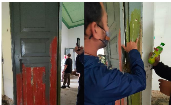
Gambar 11. Proses restorasi pintu (sumber: Hepta Desain, 2021)
