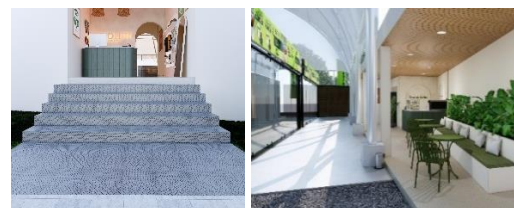
Gambar 8. Kondisi perbedaan elevasi
