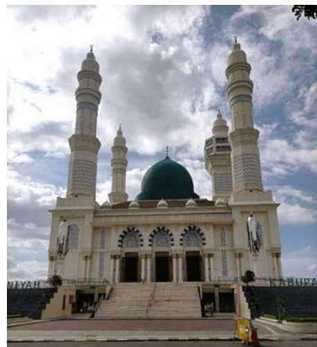
Gambar 2. Fasad Masjid Madaniyah (Sumber: Dokumen penulis, 2025)
