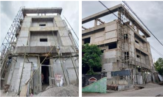
Gambar 2. Tampak Selatan. Gambar 3. Tampak Barat (Sumber: Dokumentasi Penulis, 2025 https://earth.google.com/earth/d/1HKuLhUU7oGsy0kmSUU7od34SpXBC9qet?usp=sharing )
