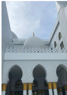
Gambar 7. Kubah Pendukung bagian antara Kubah Depan dan Menara (Sumber : Dokumentasi Penulis, 2025)
