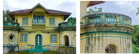
Gambar 29. Dinding Eksterior Bangunan dan Balkon (Sumber: Dokumen Pribadi, 2021)
