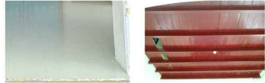
Gambar 26. Lantai Keramik dan Lantai Papan Kayu (Sumber: Dokumen Pribadi, 2021)
