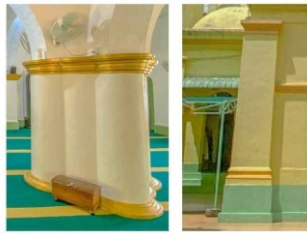
Gambar 14. Kolom Bulat dan Persegi pada Masjid (Sumber: Dokumen Pribadi, 2021)
