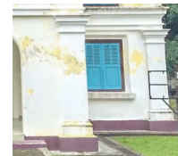
Gambar 28. Kolom dan List Profil Bangunan (Sumber: Dokumen Pribadi, 2021)
