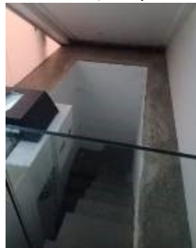
Gambar 18. Pintu Ruang Bawah Tanah (Sumber: Dokumen Penulis, 2021)
