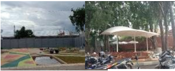
Gambar 27. Pembangunan Taman Tematik (Sumber: Dokumentasi Penulis, 2021)
