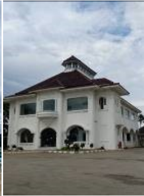
Gambar 14. Fasad Gedung Juang 45 (Sumber: Dokumentasi Penulis, 2021)
