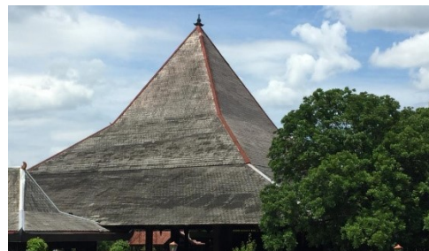
Gambar 3. Atap Bangunan Pendopo (Sumber: Survei, 2021)
