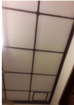
Gambar 17. Plafon 2 (Sumber: Survey, 2021)
