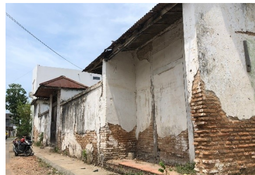
Gambar 6. Fasad Bangunan Belum Terevitalisasi (Sumber: Dokumentasi Penulis, 2021)
