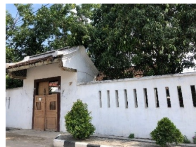
Gambar 16. Tembok keliling (Dokumentasi Penulis, 2021)
