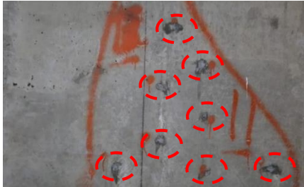
Gambar 8. Dinding Retak Setelah Dilakukan Suntik Injeksi
