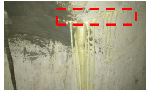
Gambar 6. Suntik Injeksi Pada Dinding Basement yang Retak
