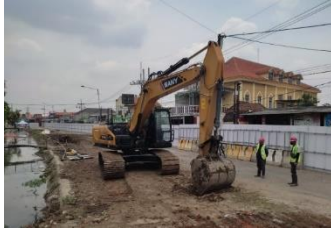
Gambar 5. Excavator (Dokumentasi Pribadi)
