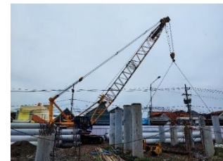
Gambar 4. Crane Service (Dokumentasi Pribadi, 2022)
