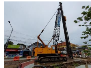
Gambar 3. Crane Pancang (Dokumentasi Pribadi, 2022)
