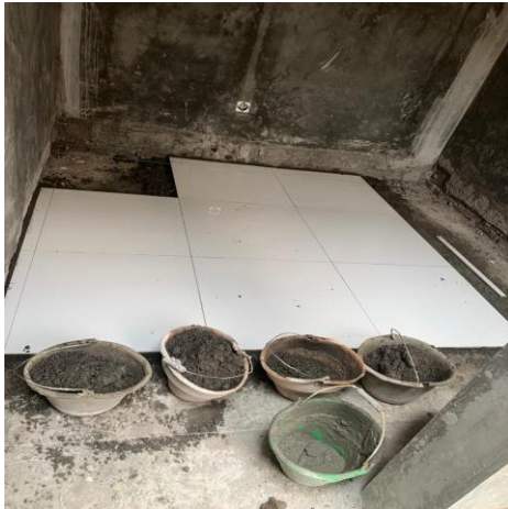
Gambar 5. Pekerjaan Pemasangan Keramik
