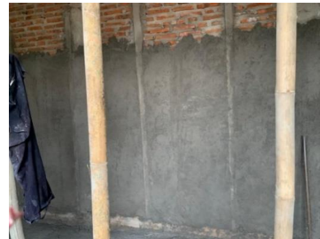
Gambar 4. Pekerjaan plesteran
