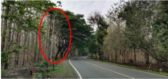
Gambar 9. Kondisi jalan dan lingkungan Segmen 5
