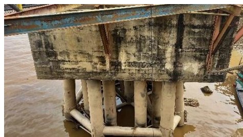
Gambar 10. Reaksi alkali-silika pada beton
