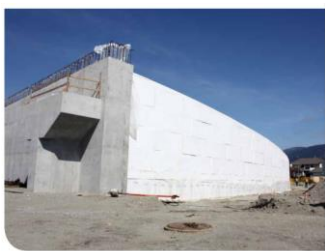
Gambar 5. Geofom sebagai timbunan oprit jembatan.
