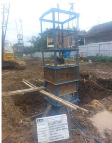
Gambar 3. Pengaturan PDA untuk pengujian tiang (dokumentasi)
