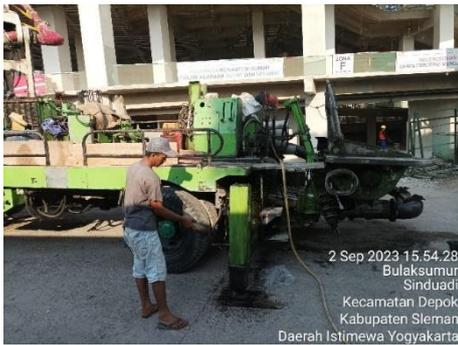
Gambar 2. Pengecoran dengan *Concrete Pump*
