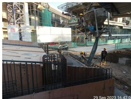
Gambar 1. Pengecoran dengan *Tower Crane*
