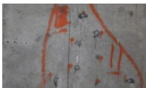
**Gambar 10. Dinding setelah diperbaiki**
