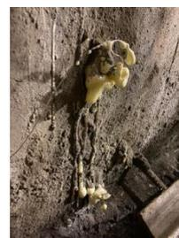
Gambar 9. Dinding setelah disuntik injeksi
