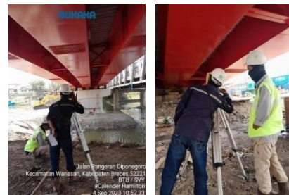
Gambar 12. Cek camber dan cek camber (after pouring concrete) (sumber : dokumentasi proyek)
