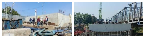
Gambar 9. Positioning dan leveling SBM ( Temporary LRB ) (sumber : dokumentasi proyek)
