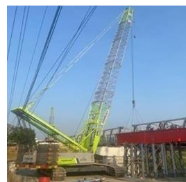
Gambar 2. Alat berat crawler crane (sumber : dokumentasi proyek)
