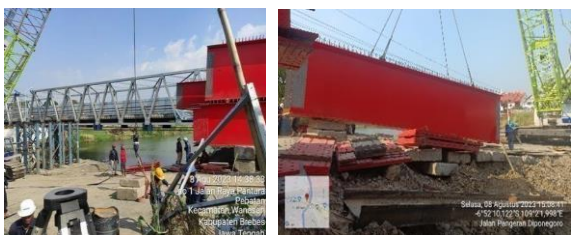
Gambar 7. Peletakan precast dan peletakan Steel Box Girder (SBG) di atas precast (sumber : dokumentasi proyek)
