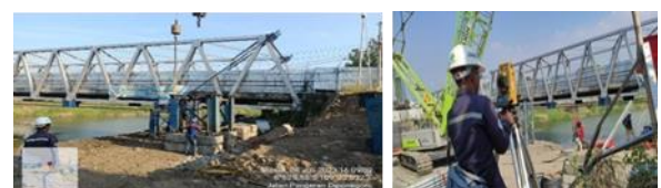
Gambar 6. Positioning atau setting shoring dan setting elevasi tambahan ganjal (sumber : dokumentasi proyek)
