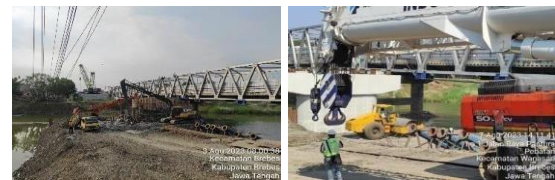
Gambar 5. Pengurugan tanah dan pemadatan tanah atau lahan (sumber : dokumentasi proyek)
