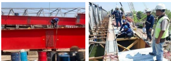
Gambar 10. Proses tightening bolt dan cek torsi (sumber : dokumentasi proyek)
