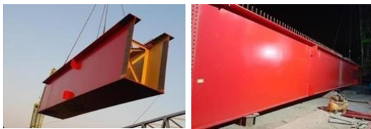
Gambar 3. Steel Box Girder (SBG) (sumber : dokumentasi proyek)
