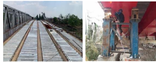
Gambar 11. Pemasangan Steel Deck dan Pelepasan Shoring (perancah) sebelum dilakukan slab jalan (Sumber : Dokumentasi Proyek)
