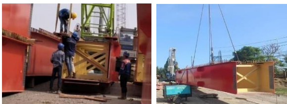
Gambar 8. Pemasangan Splice dan Baut pada Steel Box Girder (SBG) line 1 ( segment 1 ) dan Joint ( assy ) ( segment 2 ke segment 1 ) (sumber : dokumentasi proyek)
