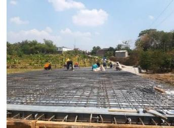
**Gambar 7. Pemasangan Floor Deck**
