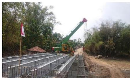
**Gambar 3. Pemasangan baja girder dengan mobile crane**
