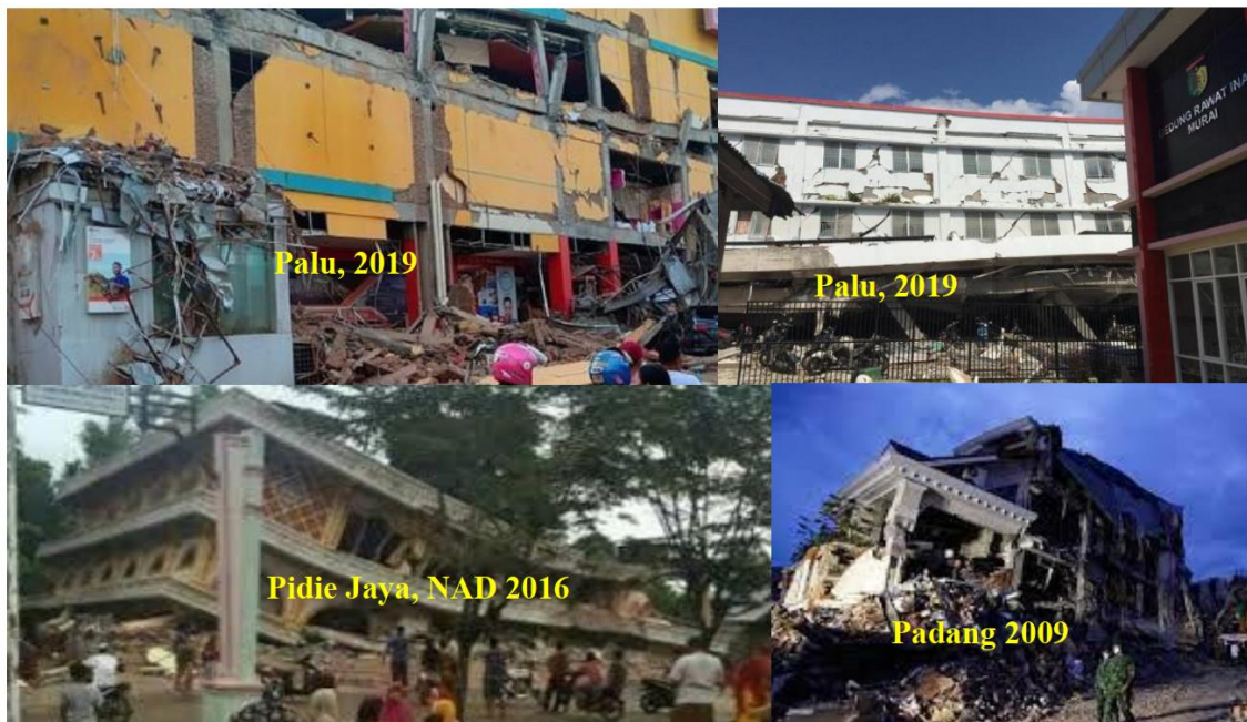
Gambar 5. Contoh struktur dengan nilai R aktual yang rendah. (sumber: AFP Photo/BNPB, Tribunnews, Itoldya)
