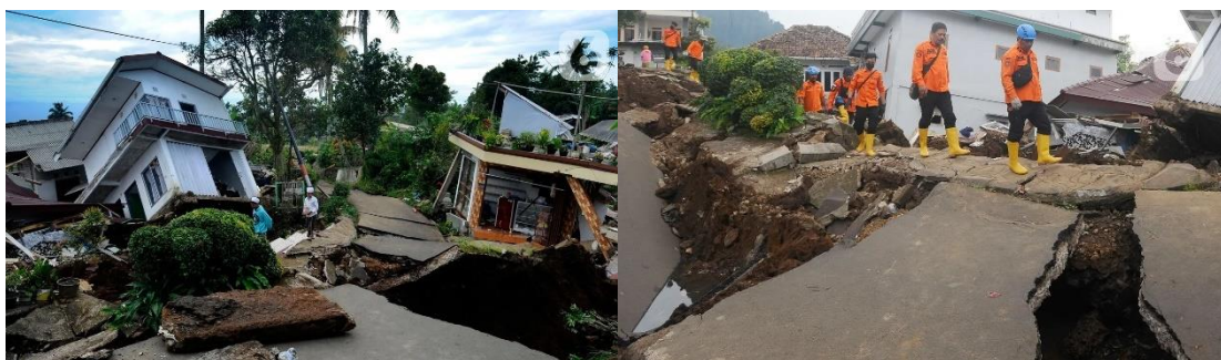
Gambar 3. Dampak gempa Cianjur (sumber: Merdeka.com)
