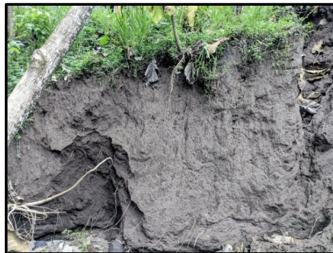
Gambar 5. Profil bidang kelongsoran tanah (SP-PC) di lokasi penelitian
