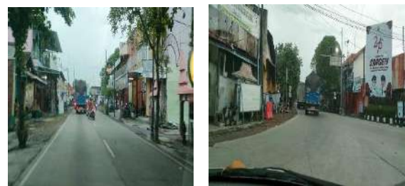
Gambar 5. Kondisi Ruas Jalan HOS Cokroaminoto
